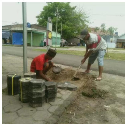
Proses pemasangan batako
