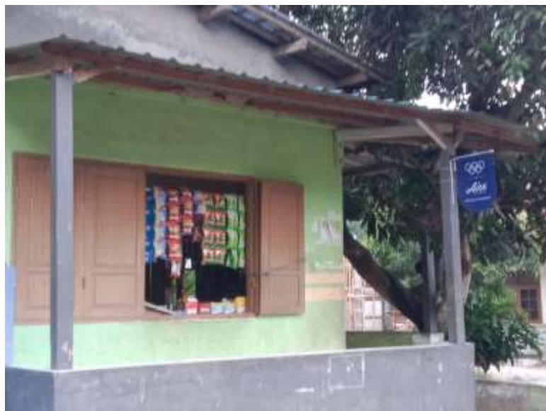
Tampak Depan Koperasi Putra
