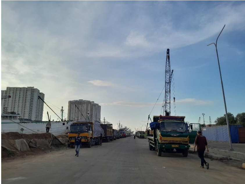
Gambar 5 kondisi pelabuhan saat ini
