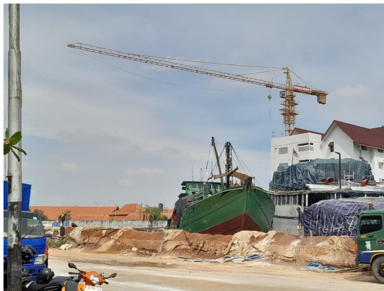
Gambar 2 Kondisi Pelabuhan Batavia Saat Ini
