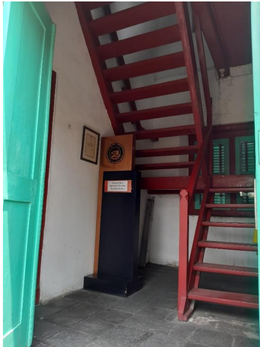
Gambar 13 kondisi dalam menara Syahbadar
