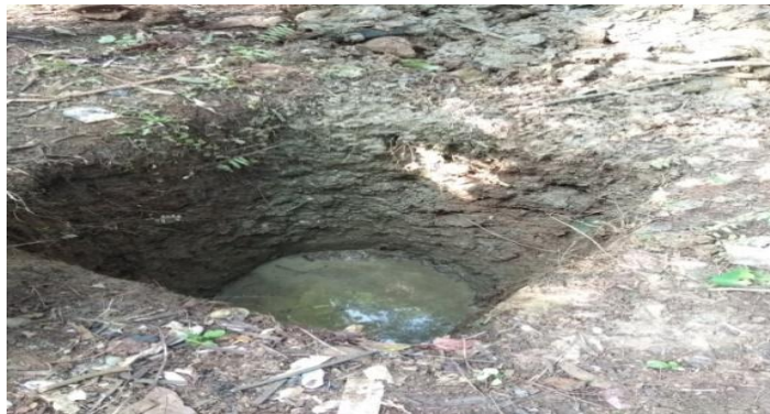
Proses menggali jamban/cubluk.
