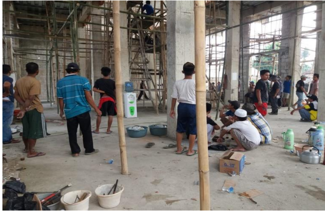
Foto pembangunan tahun 1990
