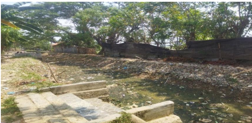
Kondisi Pesawahan dan irigasi di Desa Pontang
