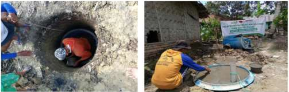
Proses Penggalian Septiktank
