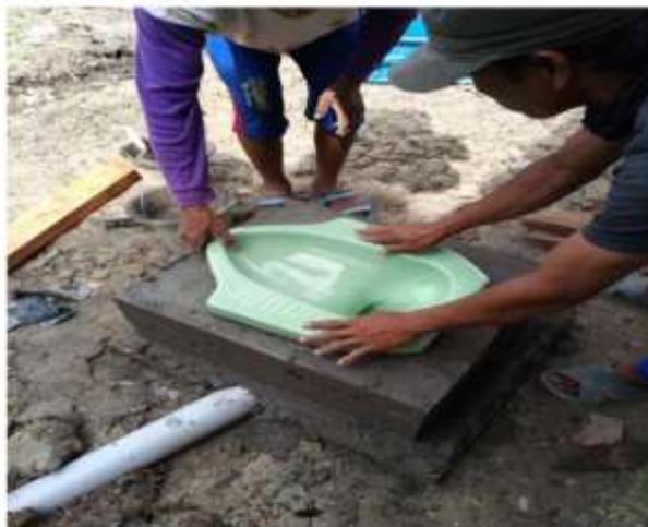
Proses Pemasangan Closet
