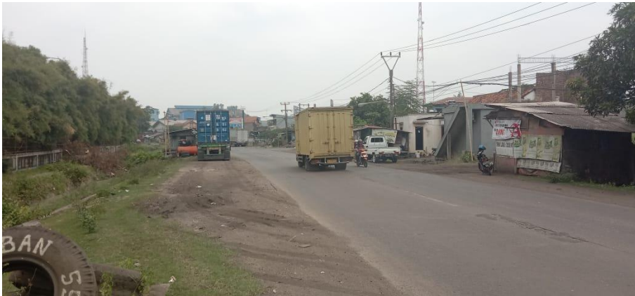
Kondisi jalanan d Jln. Raya Anyer KM 11
