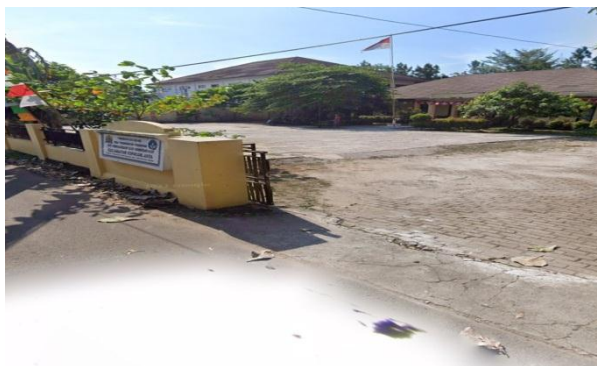
Bangunan Fisik TK Negeri Pembina Kecamatan Cipocok Jaya
